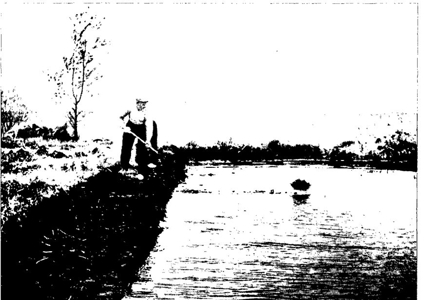
Afb. 17 Vervening: het verwijderen van de bovengrond.
